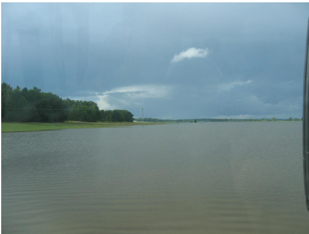
Figur 9. Foto från bro 16-730-1 mot nordväst.
