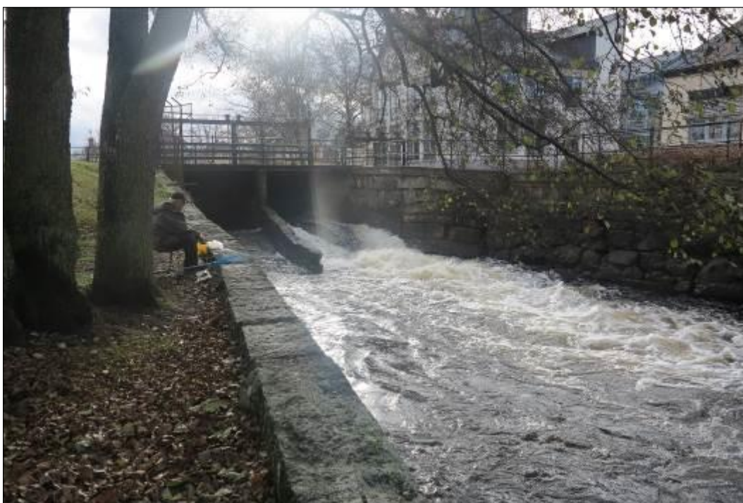
Figur 32. Vulcan B – Utskovsdamm i den högra fåran vid Vulcan som är föremål för åtgärder.
