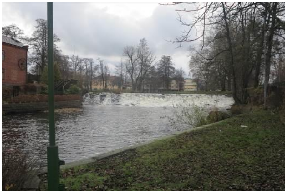
Figur 37. Överfallsdamm i Tidans huvudfåra vid Turbinhusön.
