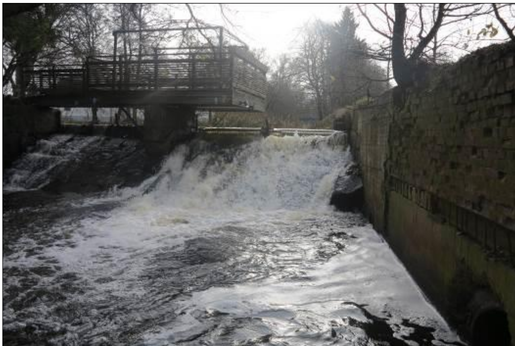
Figur 31. Vulcan A – överfallsdammen i den vänstra fåran vid Vulcan som ej är föremål för åtgärdsförslag.
